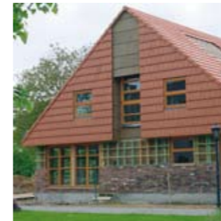
Milieu-piramide: compact bouwvolume met Celit 4D isolerende onderdakplaten.
