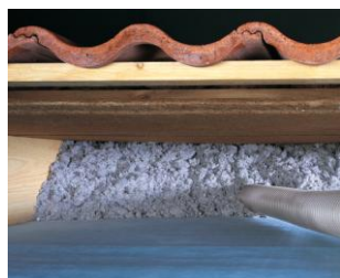
Het droog volblazen van de ruimte tussen onderdak en luchtdichting
