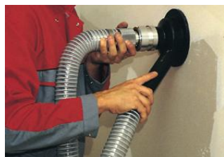
droog inblazen met behulp van een draaibare inblaaskop
