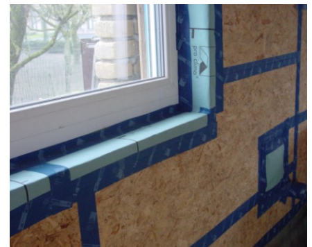
Luchtdichte aansluiting tussen het schrijnwerk en de houtskeletwand, alsook luchtdicht afgekleefde OSB-naden.
