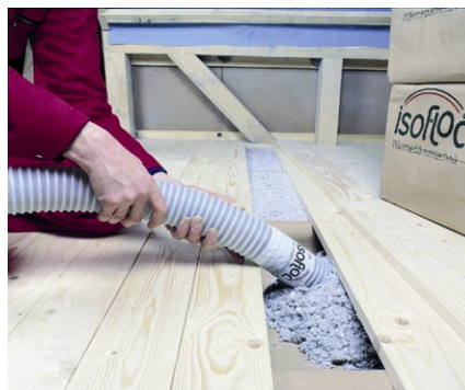
Niet alleen wanden of daken maar ook houten vloeren kunnen kierloos ingeblazen worden met isofloc cellulose isolatie.
