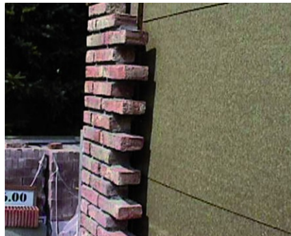
Een gevel in baksteen gaat perfect samen met een houtskelet met Celit 3D isolatiebeschermlaten.
