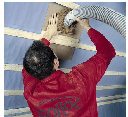
Inblazen van het dak met isofloc cellulose isolatie.
