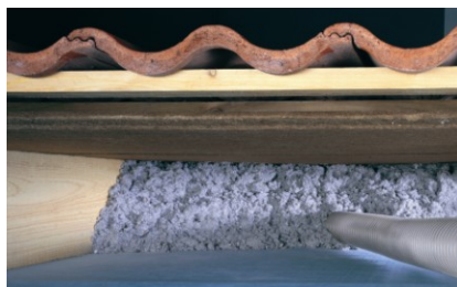
isofloc inblazen tussen Celit 4D onderdak en pro clima luchtdichting.
