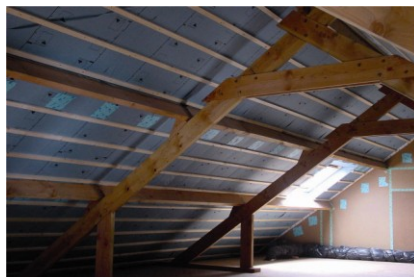
Gordingendak met pro clima luchtdichting en afgekleefde inblaasopeningen.
