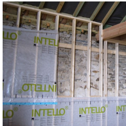
Het plaatsen van een houten structuur en een vochtgestuurde damprem pro clima INTELLO. De holle ruimte wordt kierloos gevuld met isofloc cellulose isolatie.
