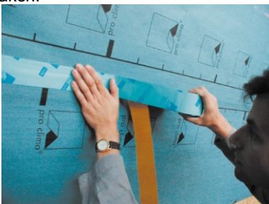
Luchtdicht afkleven van de overlappingen van de pro clima damprem met pro clima kleefband, bv. UNI TAPE.
