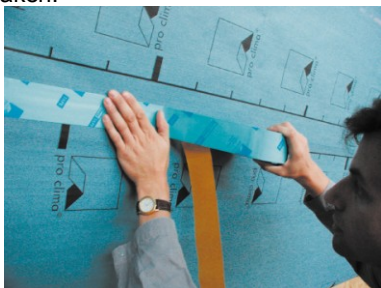
Luchtdicht afkleven van de overlappingen van de pro clima damprem met pro clima kleefband, bv. UNI TAPE.
