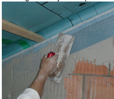
Het inpleisteren van de speciale aansluitstrook pro clima CONTEGA PV voor een luchtdichte aansluiting van de damprem (of schrijnwerk) met het pleisterwerk.
