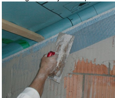
Het inpleisteren van de speciale aansluitstrook pro clima CONTEGA PV voor een luchtdichte aansluiting van de damprem (of schrijnwerk) met het pleisterwerk.
